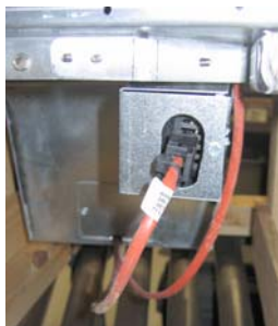
6. ábra: Csatlakoztassa a fehér két tűs csatlakozókat és csatlakoztassa a fekete dugót a dobozhoz a képen látható módon. * Megjegyzés: a fekete csatlakozó helye letérhet a képen láthatótól.
